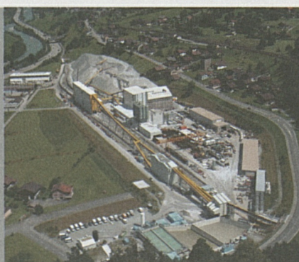
Luftaufnahme von der ATG-Baustelle Amsteg.
