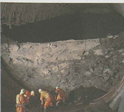
Komplexe Ausbruchsarbeiten in Faido.
