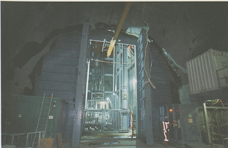
Der zweite Vertikalschacht von Sedrun ist mit ...
