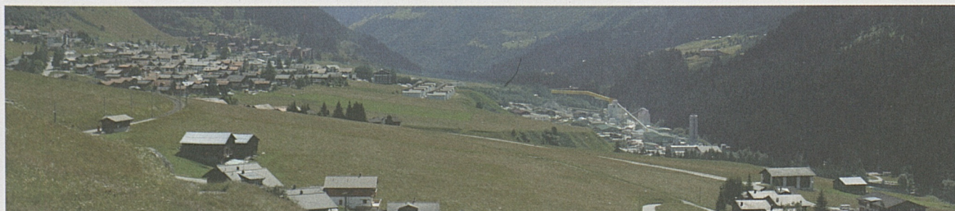
Dorf Sedrun mit Baustelle.
