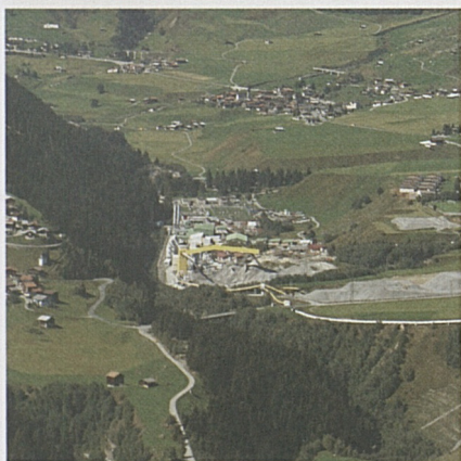
Tujetsch mit Dorf Sedrun und der Baustelle.
