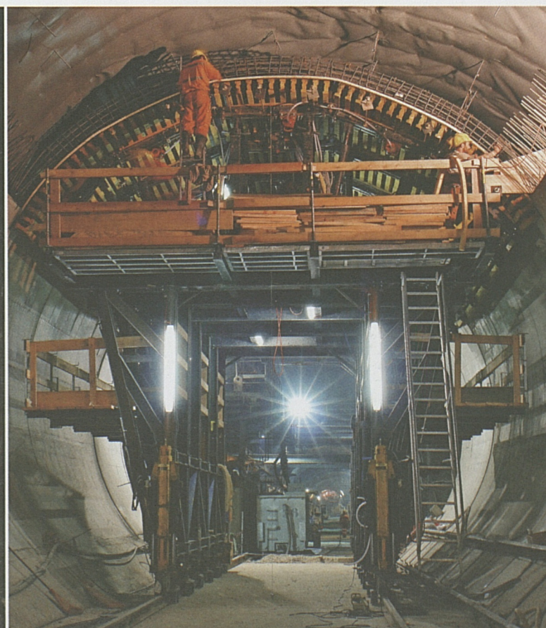
Betonarbeiten in der Multifunktionsstelle.
