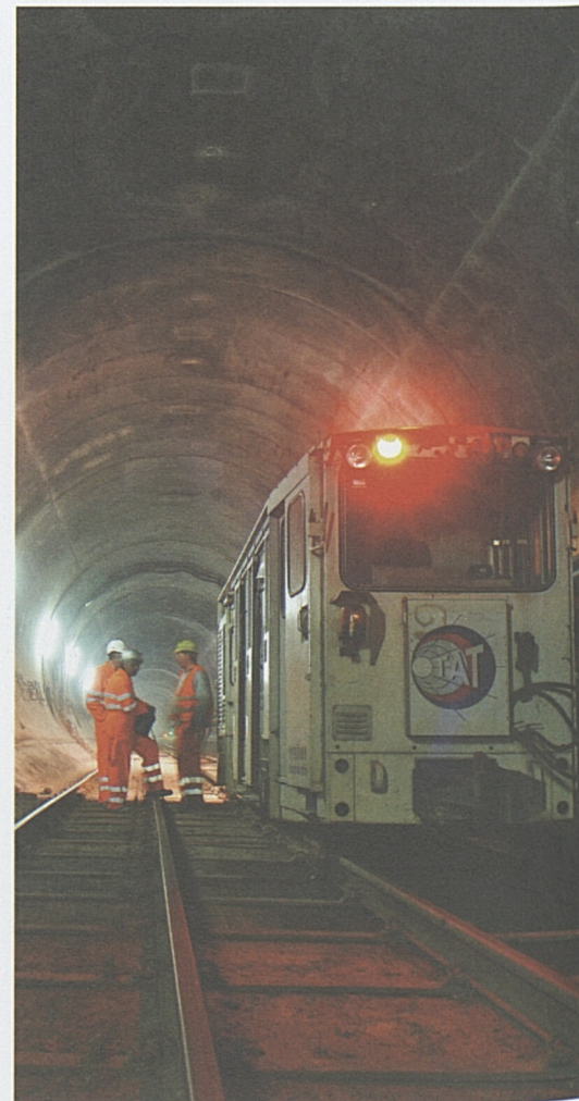
Bodio – Weströhre mit Stollenbahn und Mineuren.
