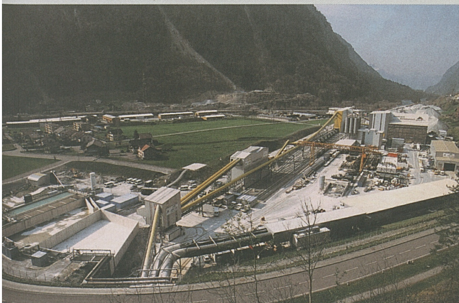
Foto: panoramica del cantiere di Amsteg.
