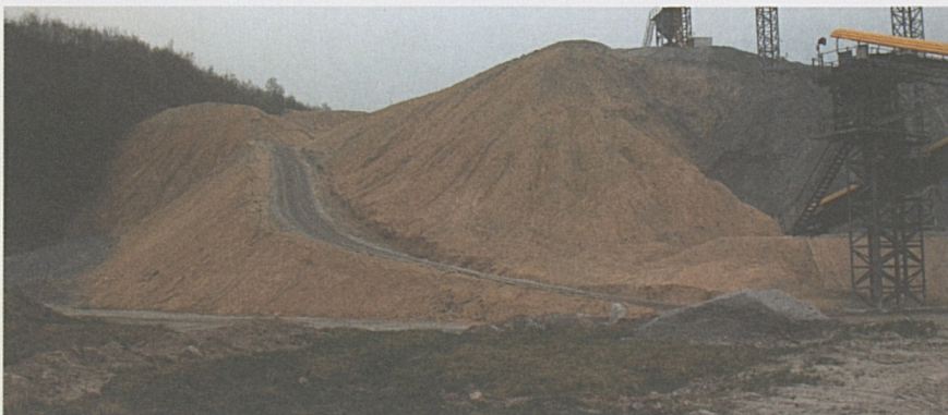
Foto sotto: dettaglio del deposito della Buzza di Biasca coperto dalla guaina vegetale antipolvere.
