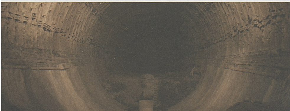
Foto sotto: avanzamento nel tubo ovest verso nord, parte di galleria rifatta.
