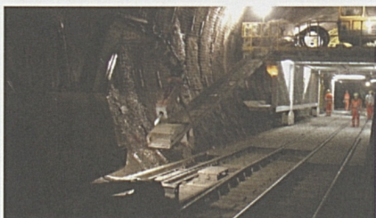
Foto sopra: i lavori di riprofilatura in corso.
