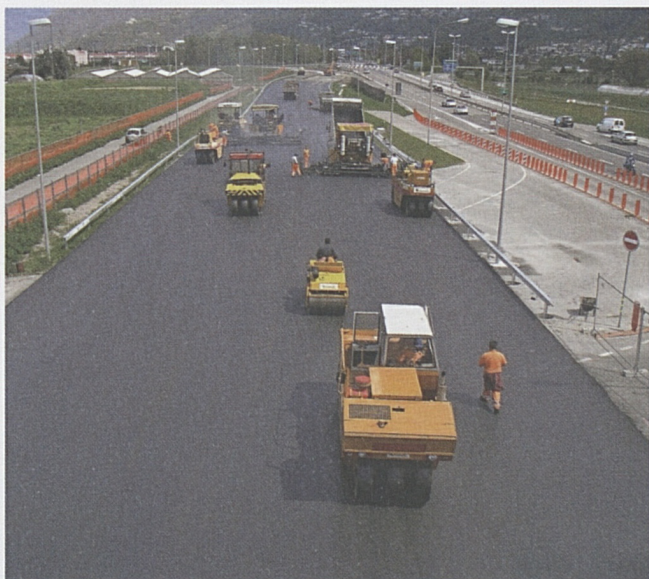
Preparazione del sedime per lo spostamento provvisorio della strada cantonale.
