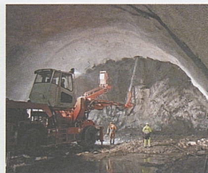
Lavori all'interno della CAOP.
