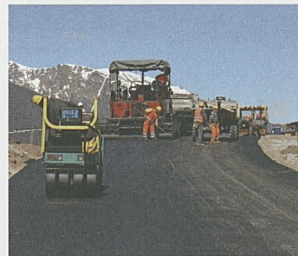
Lavori per gli allacciamenti alla zona di cantiere.
