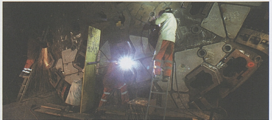
Lavori di revisione alla testa della fresa.
