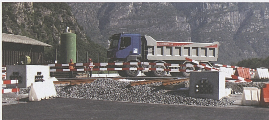
Posa del binario di cantiere.
