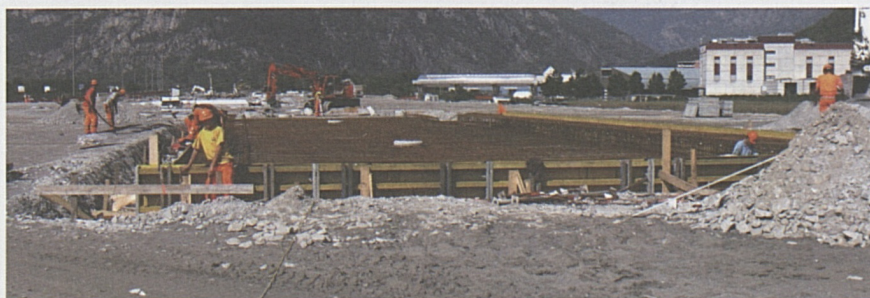
Lavori sull'area d'installazione della tecnica ferroviaria.
