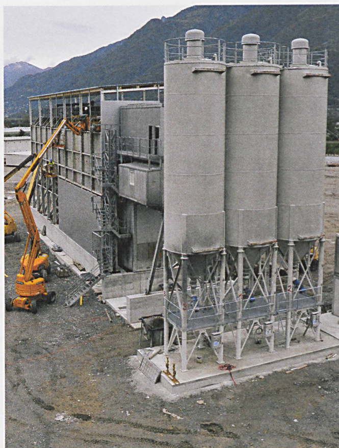
Piazzale d'installazione tecnica ferroviaria.
