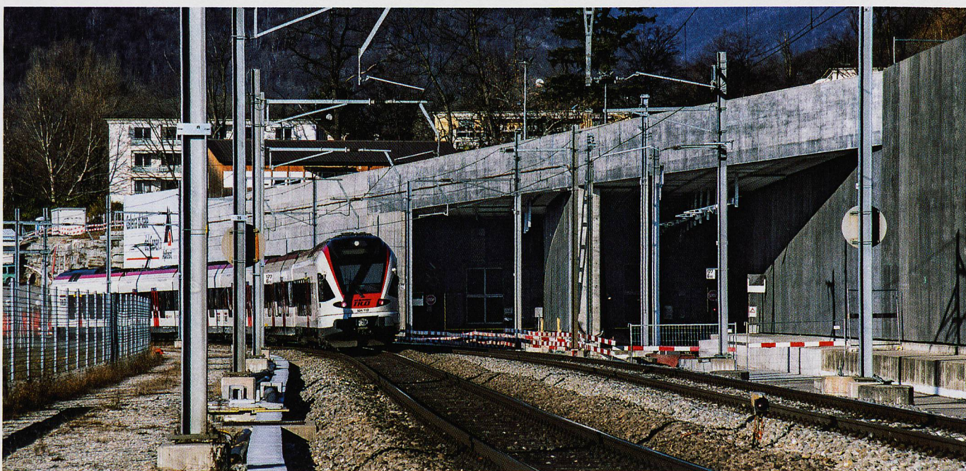
Al portale sud di Vezia, la Galleria di base del Ceneri si collega alla linea FFS esistente.
