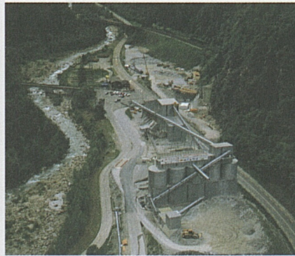
In Faido ist die eindrückliche Anlage für die Materialaufbereitung in Betrieb.
