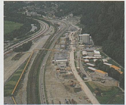
In Bodio hat man offiziell mit dem Bau des Besucherzentrums mitten im Installationsplatz begonnen.
