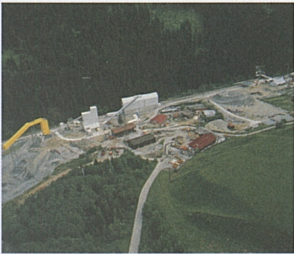
In Sedrun sind die Aussenanlagen bereit für die Arbeiten am Hauptlos.
