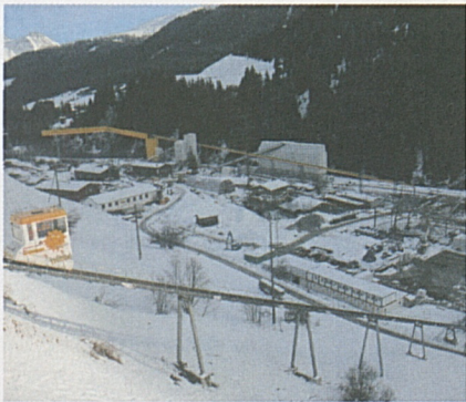
ATG-Baustelle Sedrun im Winterkleid.
