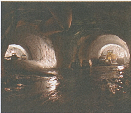
Ausbruch der Multifunktionsstelle Faido.
