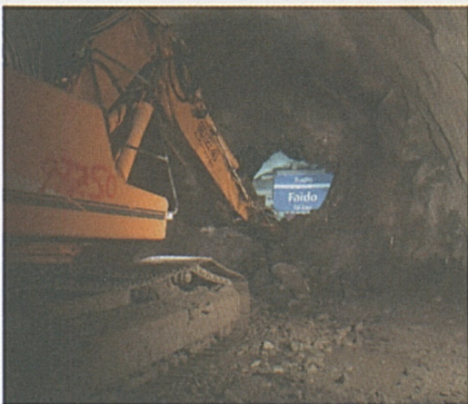
Durchstich in der Lockergesteinsstrecke.
