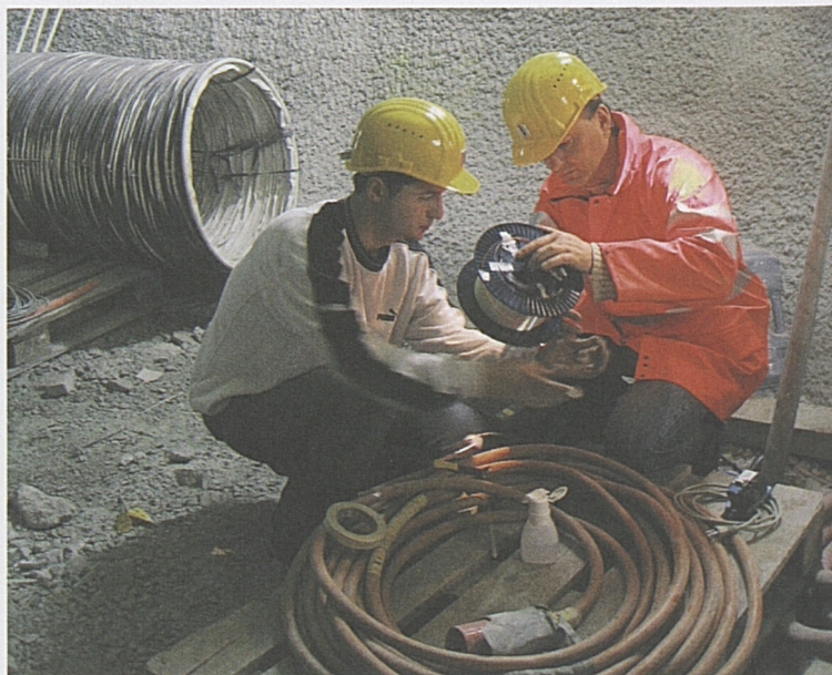
Kontrollmessung der Glasfaserkabel auf der NEAT-Baustelle Amsteg.
