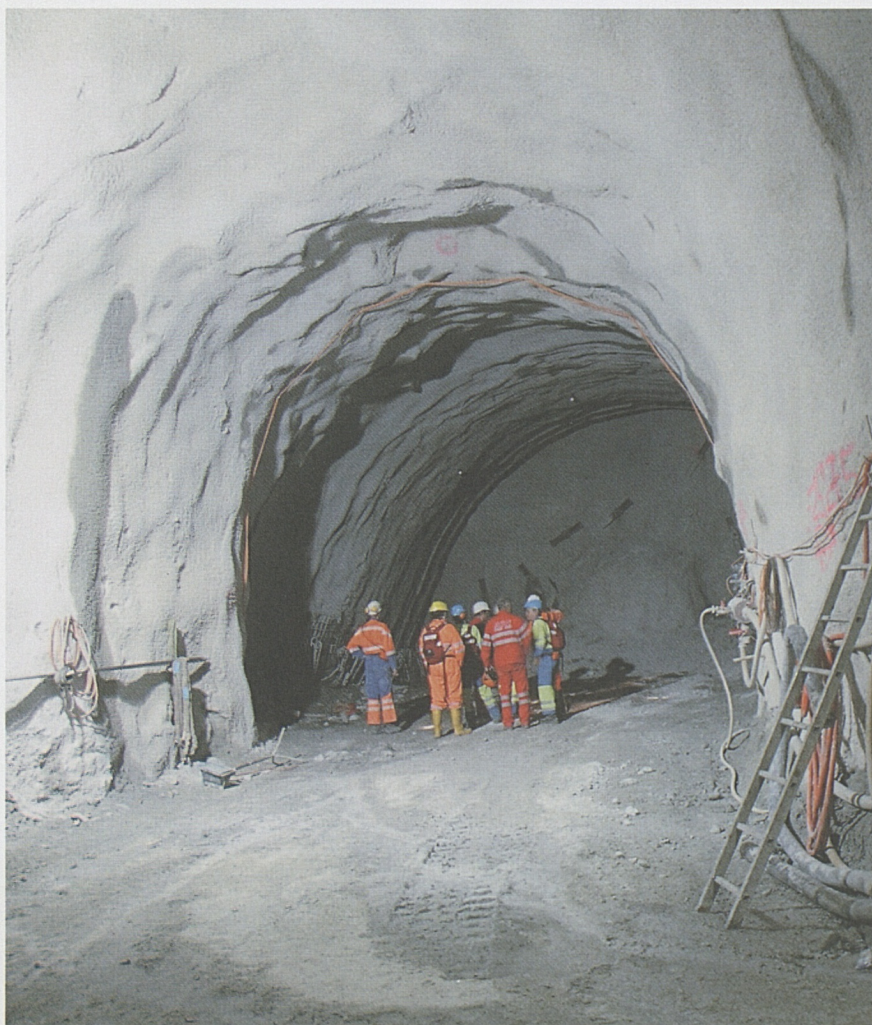
Von der Oströhre aus wurde ein rund 50 Meter langer Stollen zur Weströhre ausgebrochen.
