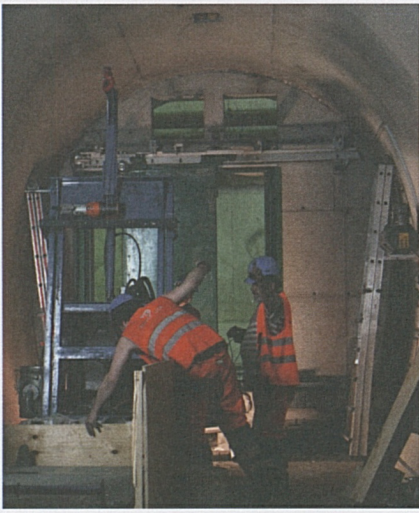
Amsteg: Einbau einer Querschlagtür.
