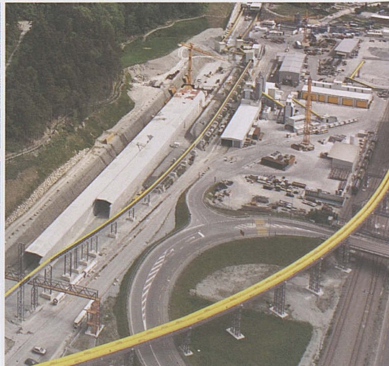
Tagbautunnel in Erstfeld.
