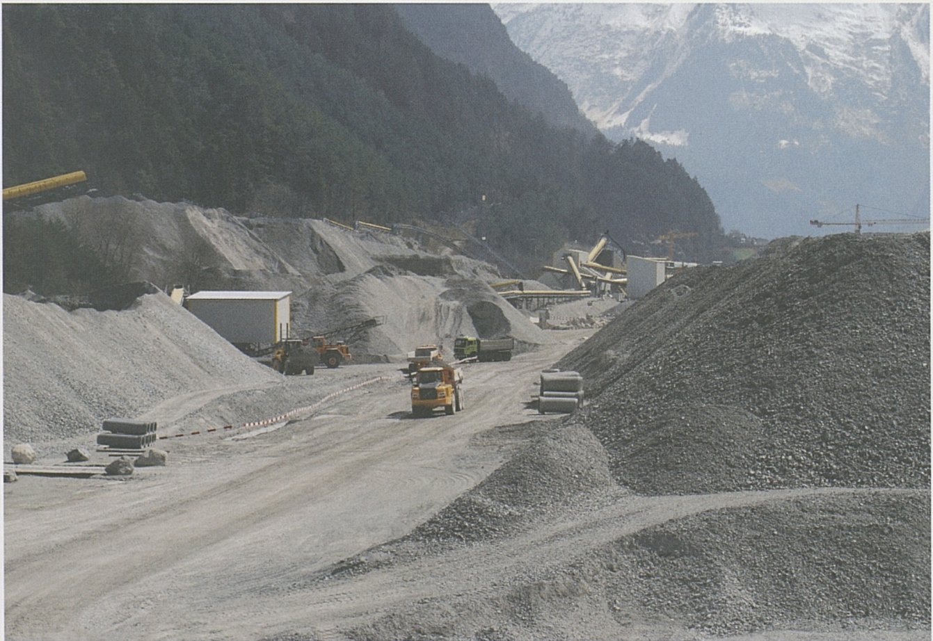
Riesige Mengen Ausbruchmaterial: Zwischenlager Chalhofen im Rynächt.
