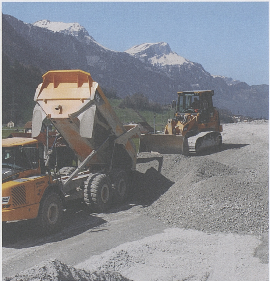
Zwischenlager Pfaffenmatt: Muldendumper bringen das Ausbruchsmaterial auf die grossen Haufen.
