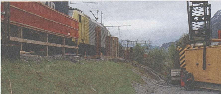
Enge Verhältnisse direkt an der SBB-Linie: Spundwände für die neue Brücke Stille Reuss.
