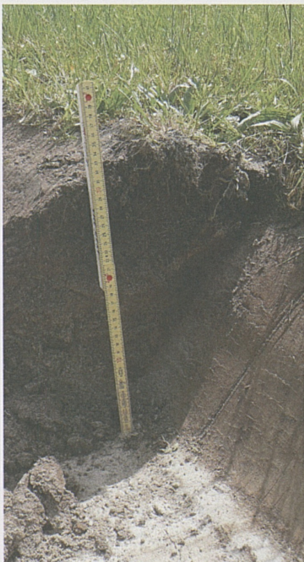
Kontrolle des Humusabtrags.
