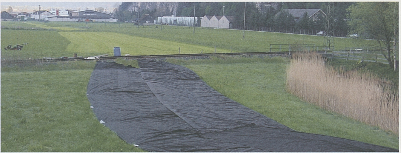
Der erste Schritt zur späteren Rekultivierung: Nachdem das Gras geschnitten und das Trennvlies ausgelegt ist, kann die Baupiste geschüttet werden.
