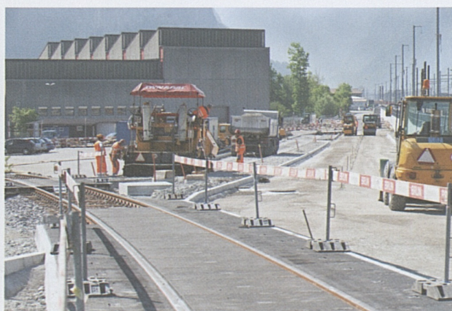
Entlang der offenen Strecke Altdorf/Rynächt wird die Kantonstrasse Stück für Stück fertiggestellt.
