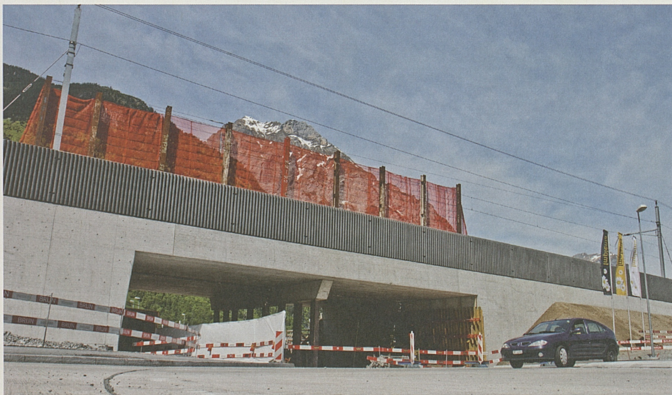
Attinghausen bekommt eine neue Zufahrt: Im Herbst 2012 wird die Unterführung Wysshus dem Verkehr übergeben.
