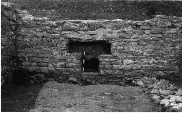
Abb. 19: Durchlass in der westlichen Mauer zum Strassenkanal, Blick von Osten.
