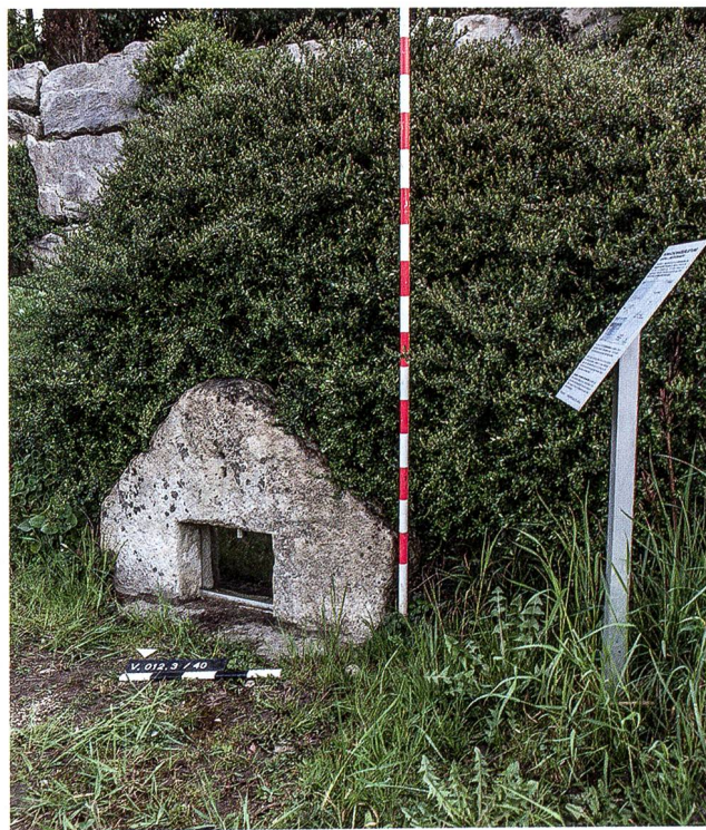
Abb. 14: Windisch-Dohlenzelgstrasse/Jurastrasse 2012–2013 (V.012.3). Blick von Nordwesten auf den sanierten Frontstein von «Schacht B» der römischen Wasserleitung.
