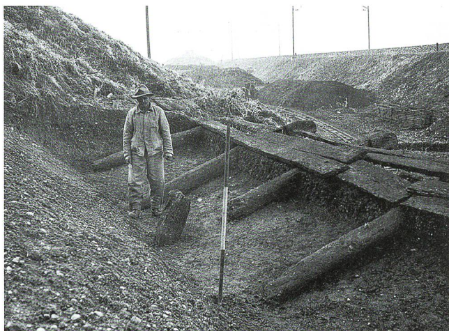
Abb. 7: Windisch, Schutthügel von Vindonissa. Ein zeitgenössisches Grabungsfoto von 1943 zeigt die seinerzeit aufgefundenen, durch spätere Schichtsetzungen verschobenen Bauhölzer mit noch intakten Querverbindungen.
