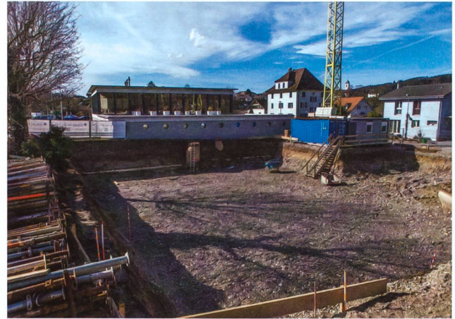
Abb. 33: Gebenstorf-Reuss 2017 (Geb.017.1). Blick von Südosten auf die fertig ausgehobene Baugrube mit der natürlichen Schichtabfolge. Im Bildhintergrund, rechts neben dem Kran, der Turm der Dorfkirche Windisch am anderen Reussufer.
