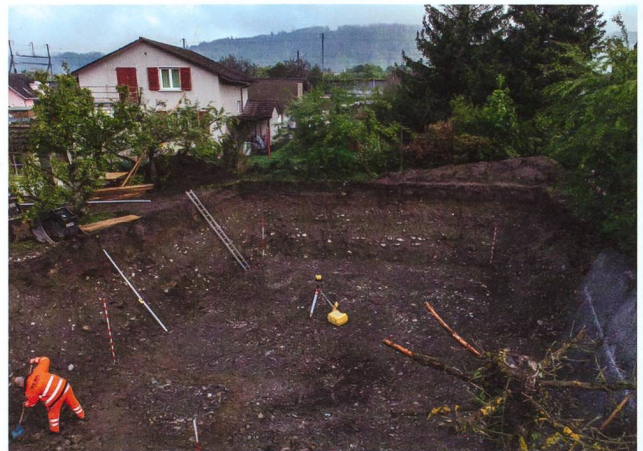
Abb. 25: Windisch-Bühlweg 2017 (V.017.3). Blick von Südosten auf die fertig ausgehobene Baugrube mit der geologischen Schichtabfolge im Bereich der Niederterrasse von Aare und Reuss. Im Hintergrund die SBB-Linie Brugg-Baden.
