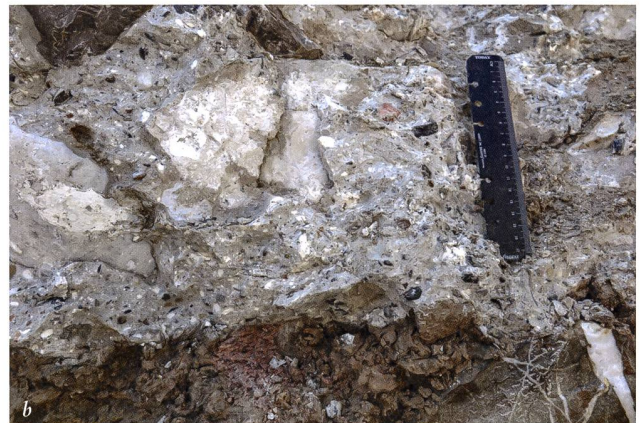
Abb. 6: Mumpf-Sanierung Kantonsstrasse (Mmp.019.2). David Wälchli und Daniel Huber (KAAG) bei der Reinigung des bei Bauarbeiten teilweise zerstörten Fundamentbereichs der spätantiken «Magazinstation» Mumpf-Burg (a). Detailaufnahme des nach wie vor «pickelharten» opus caementitium im Bereich der teilweise zerstörten Fundamentpartie (b). Gut zu erkennen sind die weissen Kalkspatzen (Klumpchen aus gelöschtem Kalk). Kalkspatzen wirken wie kleine Speicher, aus denen sich Calciumhydroxid lösen und an anderer Stelle kristallisieren kann. So können kleine Risse «verheilen» und der Mörtel erhält mehr Festigkeit.
