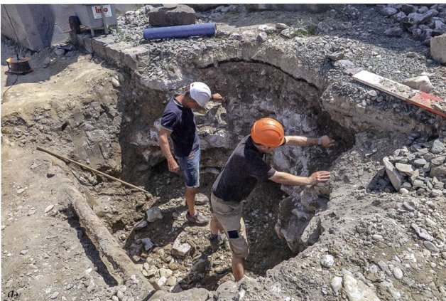
Abb. 6: Mumpf-Sanierung Kantonsstrasse (Mmp.019.2). David Wälchli und Daniel Huber (KAAG) bei der Reinigung des bei Bauarbeiten teilweise zerstörten Fundamentbereichs der spätantiken «Magazinstation» Mumpf-Burg (a). Detailaufnahme des nach wie vor «pickelharten» opus caementitium im Bereich der teilweise zerstörten Fundamentpartie (b). Gut zu erkennen sind die weissen Kalkspatzen (Klumpchen aus gelöschtem Kalk). Kalkspatzen wirken wie kleine Speicher, aus denen sich Calciumhydroxid lösen und an anderer Stelle kristallisieren kann. So können kleine Risse «verheilen» und der Mörtel erhält mehr Festigkeit.
