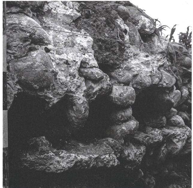
Abb. 22: Sisseln AG, Hintere Halde (1972). Nicht mehr lokalisierbare Detailaufnahme der aus mit grossen Kieselwacken durchsetztem opus caementitium bestehenden Fundamente der Nord- oder Südmauer des Mitteltrakts der spätantiken «Magazinstation». Gut zu erkennen sind die beim Verrotten der Holzarmierung entstandenen Hohlräume.
