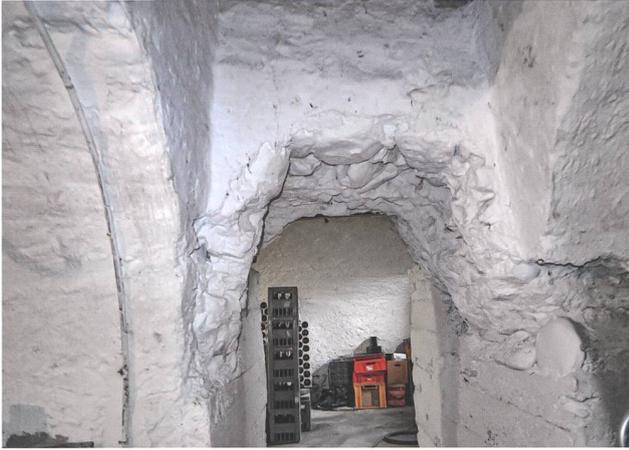
Abb. 6: Mumpf AG, Liegenschaft Hauptstrasse 93 (Gasthof zum Anker). Blick von Osten auf den Durchgang zwischen Keller 35 und Keller 37. Der Durchgang wurde 1949/50 aus dem beim Bau der Liegenschaft (1829) unterfangenen Fundament der Ostmauer des Mitteltrakts der spätantiken «Magazinstation» ausgeschrotet. Die UK des spätantiken *opus caementitium* entspricht der OK der 1998 erstellten Betonunterfangung (Zustand 2017).
