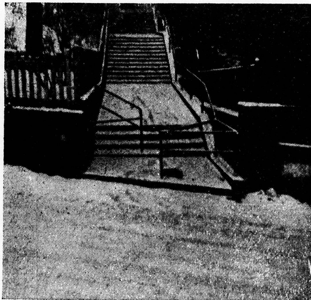
Ausmündung der Treppe nach Erstellen des Schutzgitters
