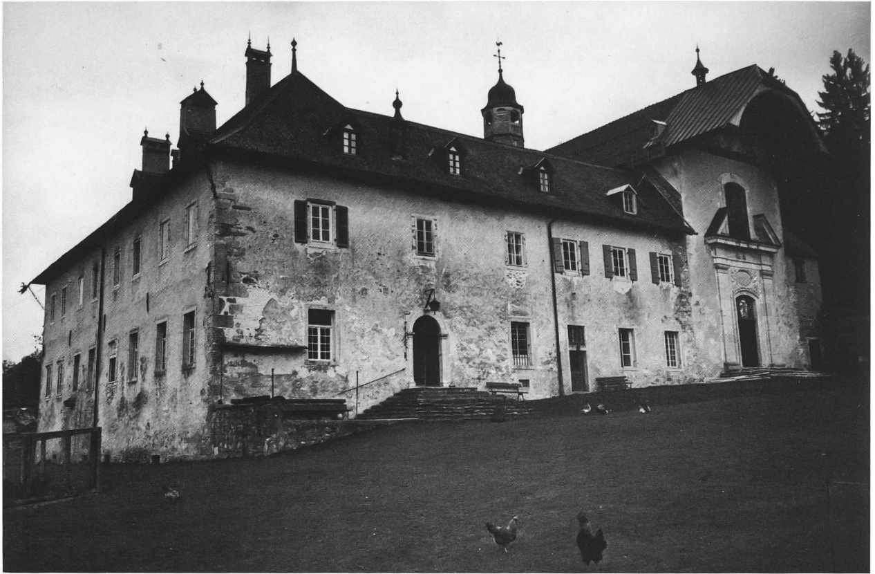
33 La Part-Dieu, le bâtiment principal et l'église. Photo mai 1990.
