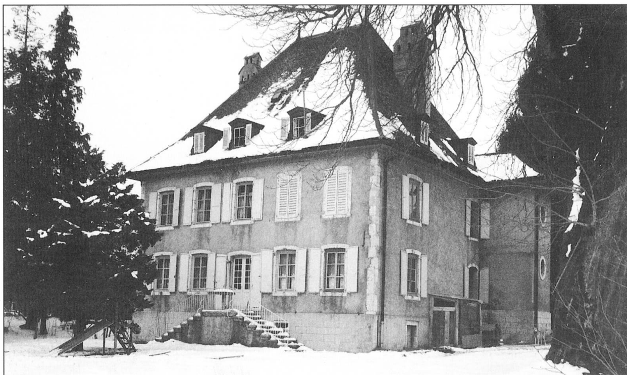
Charmey. Le château de la Corbettaz, bâtiment rénové en 1835 par Jean-François-Cyprien de Pettolaz.
