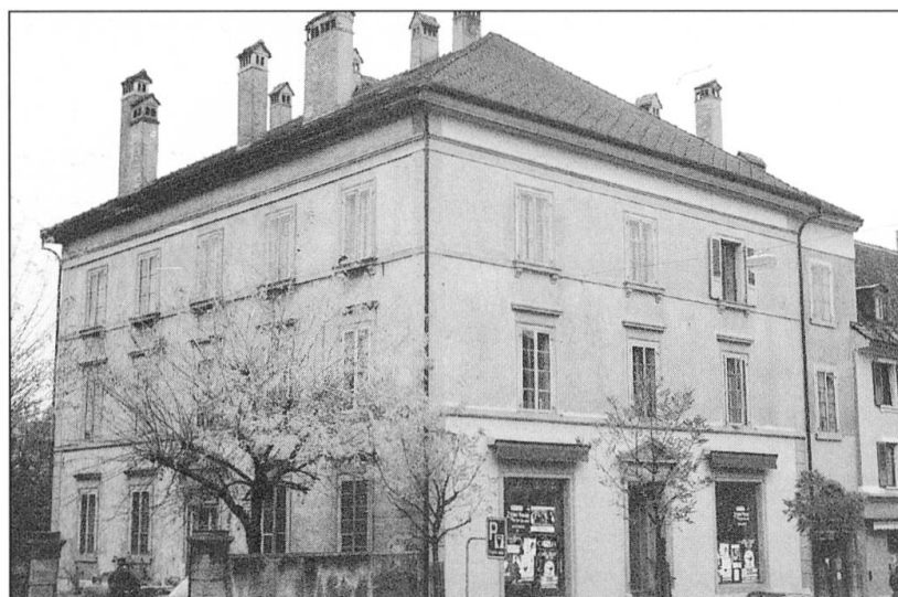
Bulle. Bâtiment de la Grand-Rue, construit en 1838 par Jean-François-Cyprien de Pettolaz.
