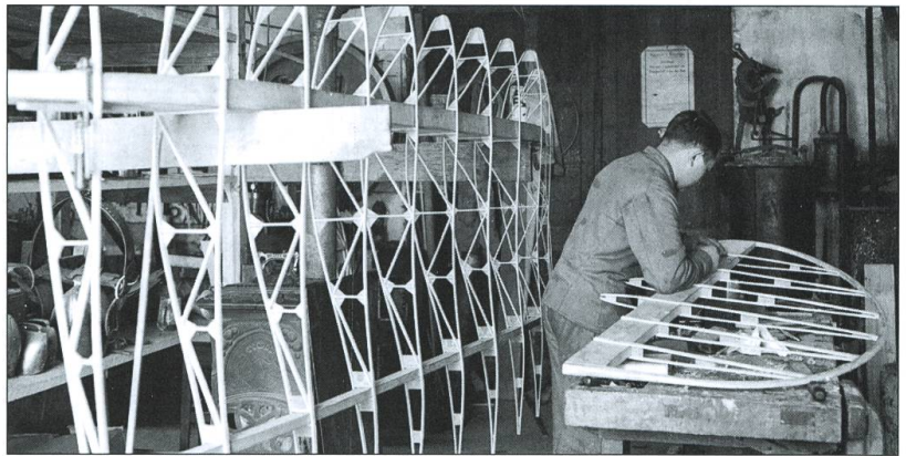
Ateliers Firmann, Bulle, 1936. Fabrication du planeur de l'aviateur Cosandey: Le Pou du Ciel. © Photo Glasson, Musée gruérien Bulle
