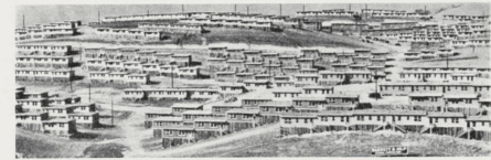
Die Frage der demontierbaren Häuser spielte für die großen Industriesiedlungen eine hervorragende Rolle. Ein Teil dieser Siedlungen wird nun demontiert und nach England verfrachtet.
