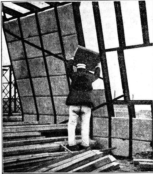
Plaques pour toiture et parois en béton cellulaire de 8 cm d'épaisseur, poids sp. 0,7, revêtu de crépis, treillis et carton bitumé.
