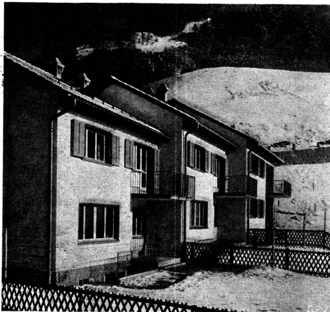
Le Groupe de trois maisons mitoyennes vu de l'angle sud-ouest.
