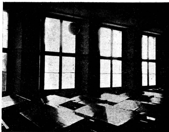
Mauvais éclairage : Les trumeaux jettent des ombres sur certains pupitres. Le rythme des murs et vitrages fatigue les yeux. Assombrissement du fond de la classe. Appui et couverte des fenêtres trop importants. Impression d'être emprisonné.
