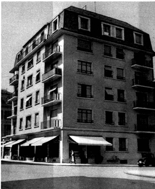
Immeuble rue du Mont-de-Sion, 3, Genève
