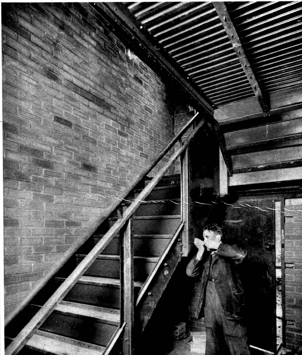
Montage de la balustrade de l'escalier.
