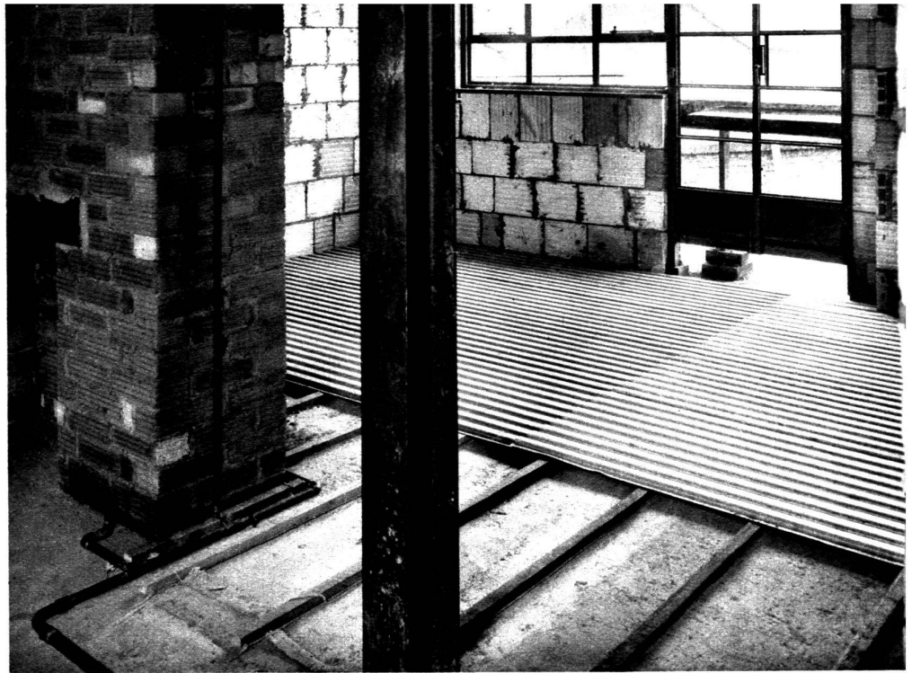
Vue du plancher « flottant » posé sur lambourdes et amiante.
