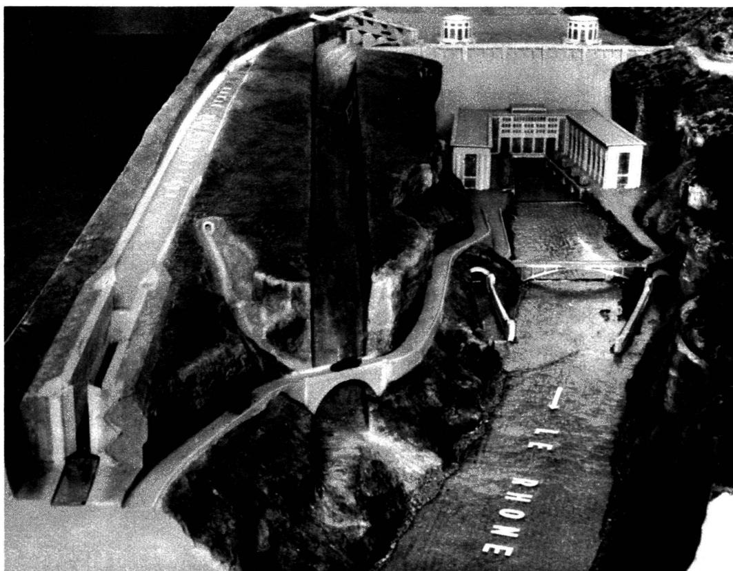
La maquette montre, à gauche, le canal et l'écluse de navigation ; au centre, le canal pour l'écoulement des crues du fleuve ; à droite, le Rhône avec l'usine hydro-électrique et, au fond, le grand barrage surmonté des tours de prise d'eau. De chaque côté de l'usine, on aperçoit la sortie des canaux souterrains destinés à l'écoulement des eaux qui auront alimenté les turbines de l'usine.
