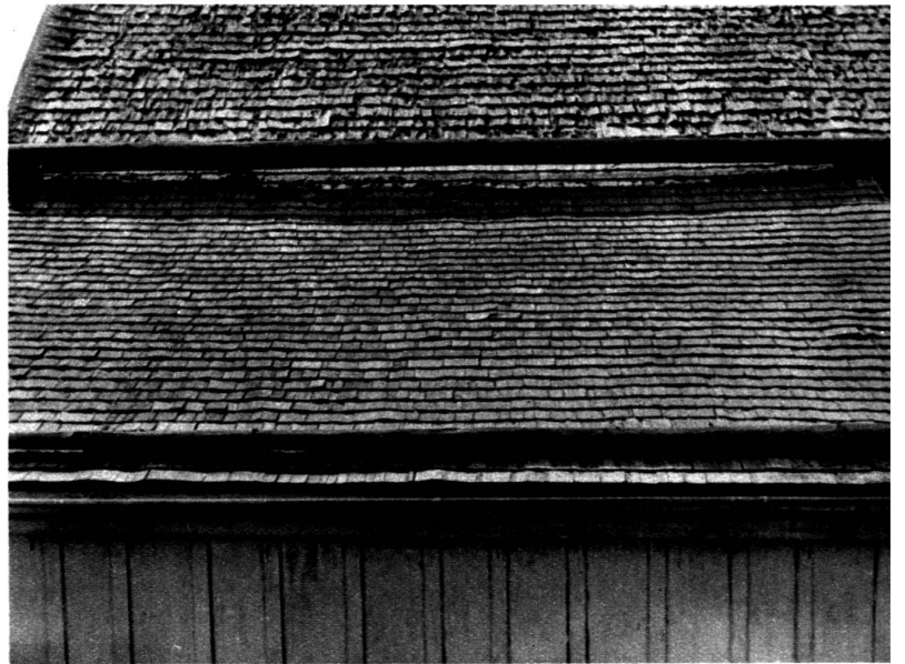
Utilisation des favillons sur toiture avec barres à neige. On remarquera la différence entre les favillons récents et anciens.
