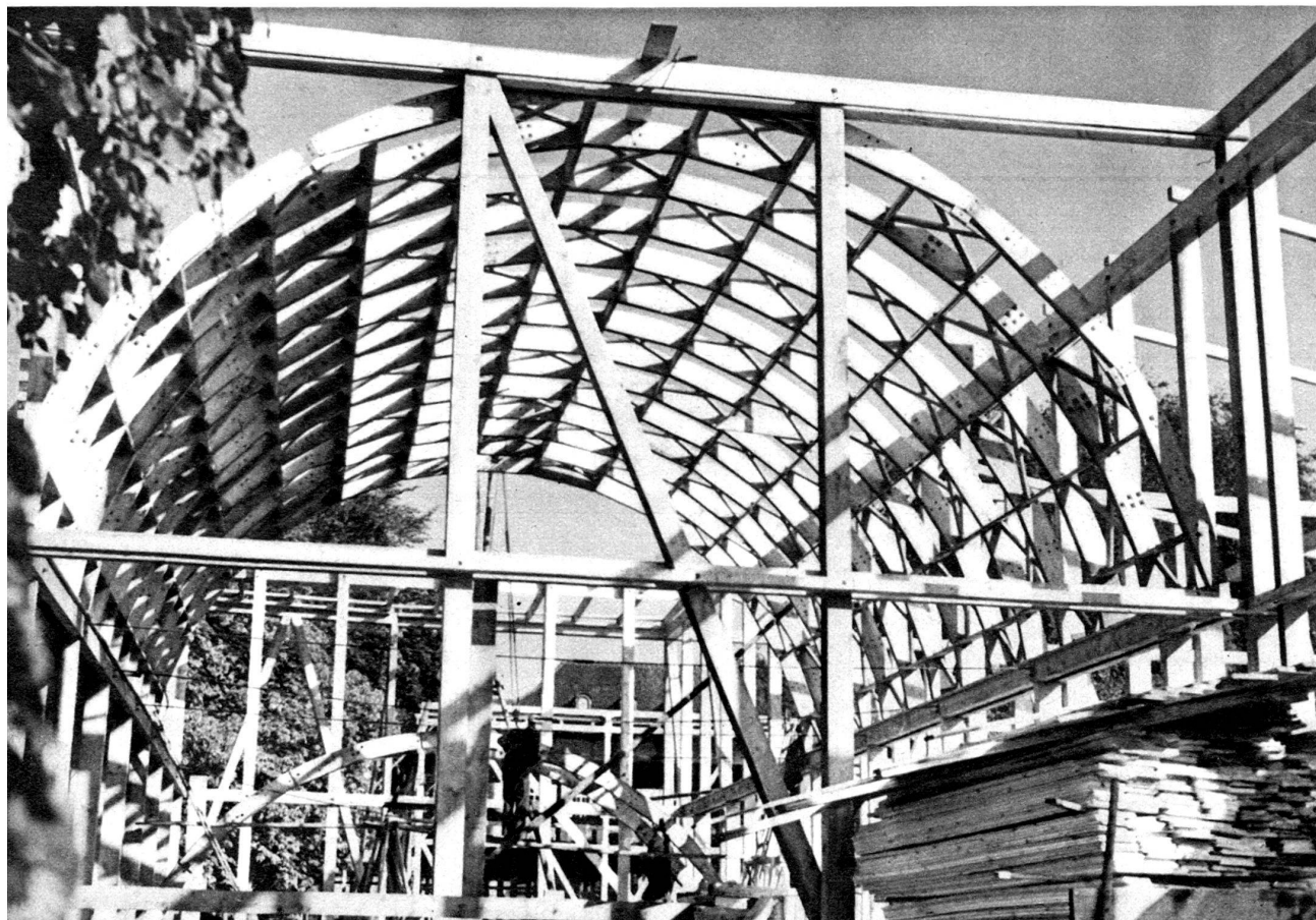
Le pavillon du cinéma laissera voir aux visiteurs sa charpente faite entièrement en planches, selon le système d'un inventeur suisse romand, M. J.-L. Badel.
