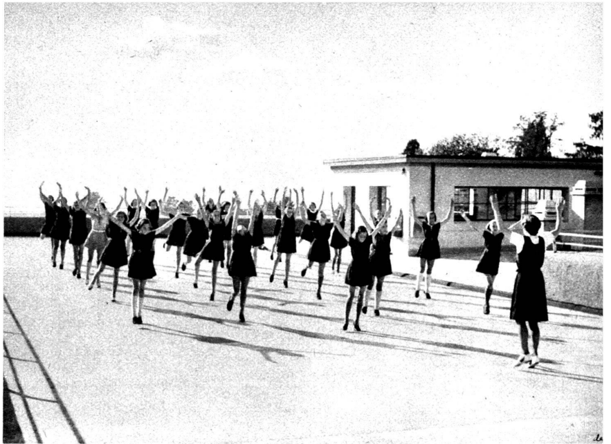
Utilisation de la toiture.
