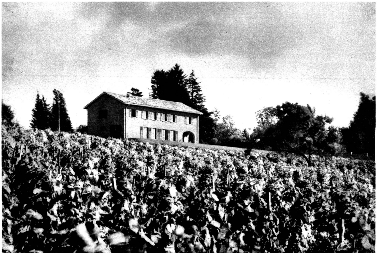
Seconde catégorie (plus de 40,000.—). 3 me diplôme. Chemin de Sous-Caran. Frédéric Gampert, architecte F. A. S. (Cette construction a été publiée avec plans et détails dans le N° 12, décembre 1938.)
