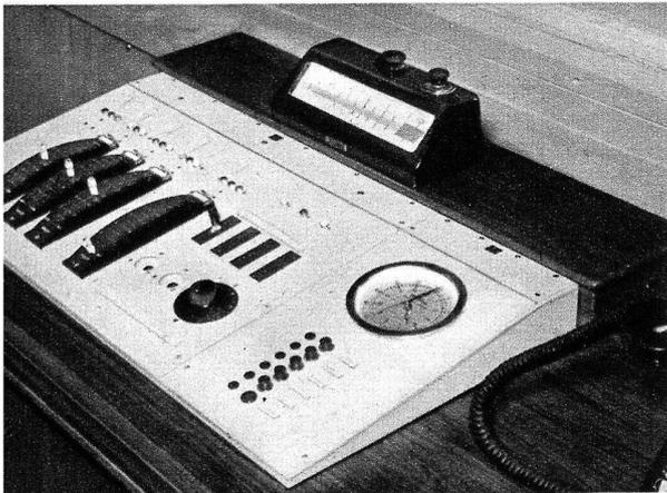
Pupitre de réglage avec instrument à index lumineux.
