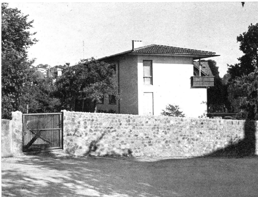
Vue de l'ouest.
