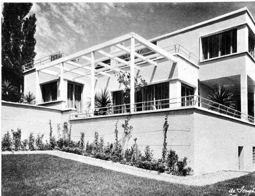
Vue du sud-ouest.
