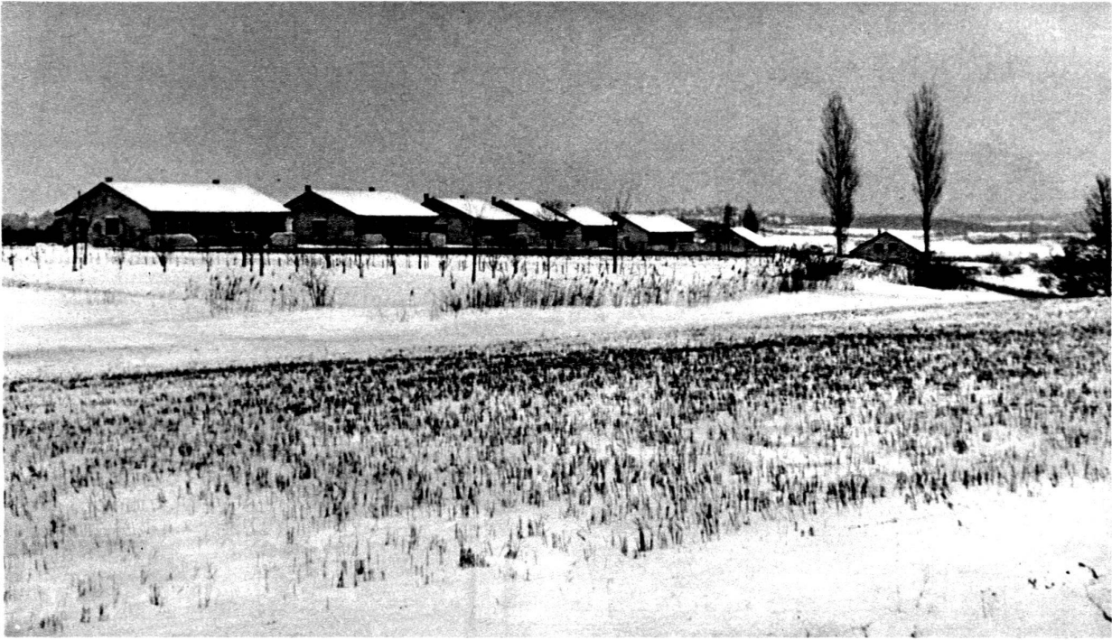
Vue générale du sud-ouest.
