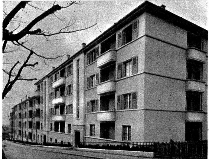
Façade sur le chemin de Fontenay.
