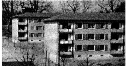
Un immeuble de la Cité Vieusseux.
